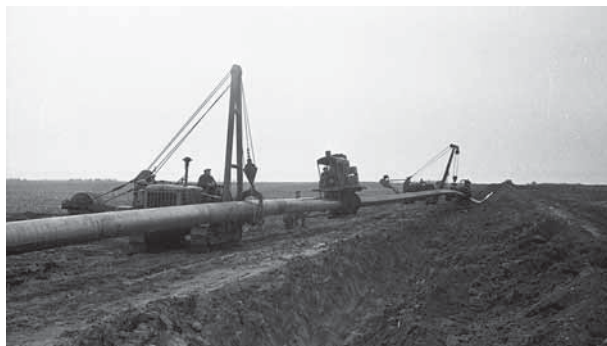
Будівництво газопроводу на відрізку Яготин – Черкаси
